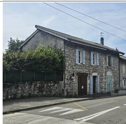
Photo PhDPE002 Ouvrage : Nord-Est
