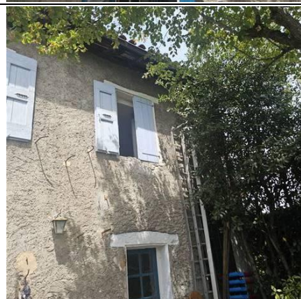
Photo PhDPE003 Ouvrage : Sud
