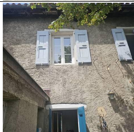
Photo PhDPE003 Ouvrage : Sud
