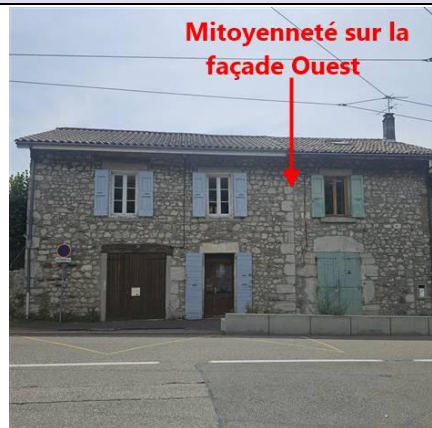
Photo PhDPE001 Ouvrage : Nord
